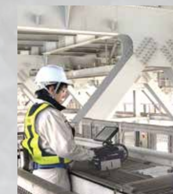
赤外線カメラを用いた橋梁診断技術の開発
